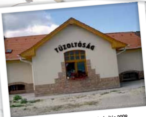
Törökszentmiklós, Tűzoltószertár építés 2009.
