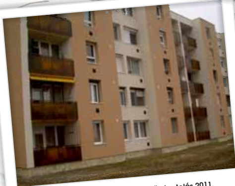
Szolnok, Bimbó u. Homlokzat hőszigetelés 2011.
