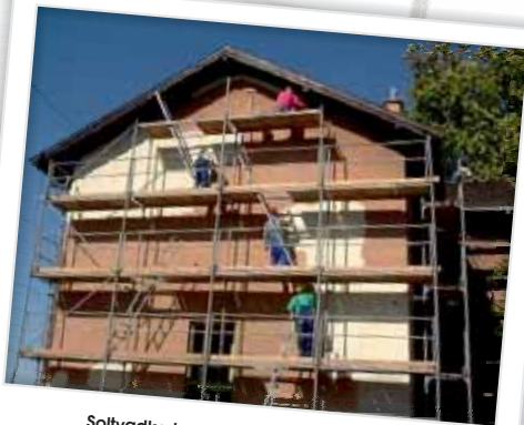
Soltvadkert, vasútállomás felújítás 2007.
