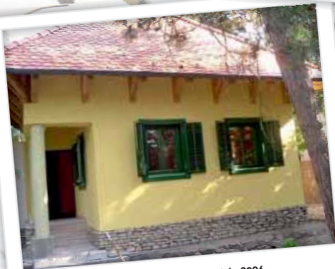
Zamárdi családi ház építés 2006.
