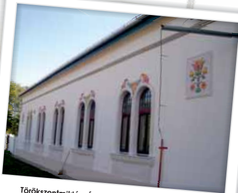
Törökszentmiklós, Óvoda homlokzat felújítás 2014.
