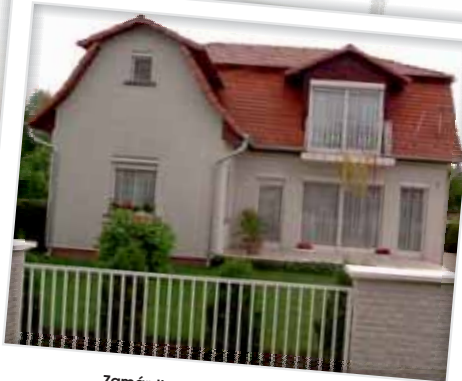
Zamárdi családi ház építés 2001.
