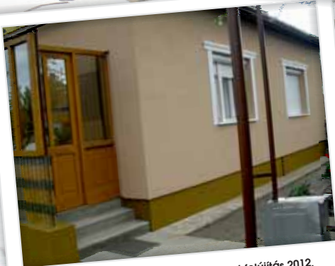
Rákóczi, Családi ház homlokzat felújítás 2012.
