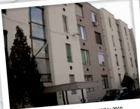
Mezőtúr, Társasház Homlokzat felújítás 2010.
