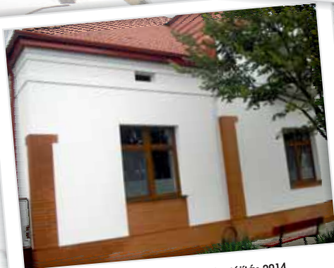
Tiszaföldvár, Orvosi rendelő felújítás 2014.
